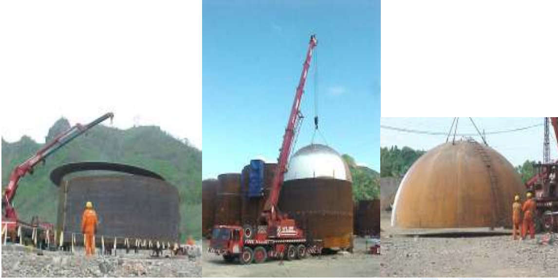
Resim 4.4.3. Gömülü sıvılaştırılmış gaz (LPG) depolama tankları yapımı [11]
